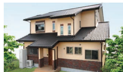
2012年2月施工 将来を考え、家族の成長に合わせて変化する住まい。
