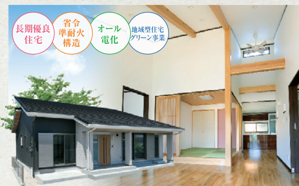
鳥栖市(2018年4月竣工)
